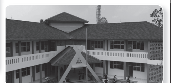
(Pembangunan Unit Gedung Baru SDN Citareup 06, Kabupaten Bogor).
