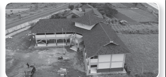
(Pembangunan Unit Gedung Baru SDN Cidageng 01, Kabupaten Bogor).
